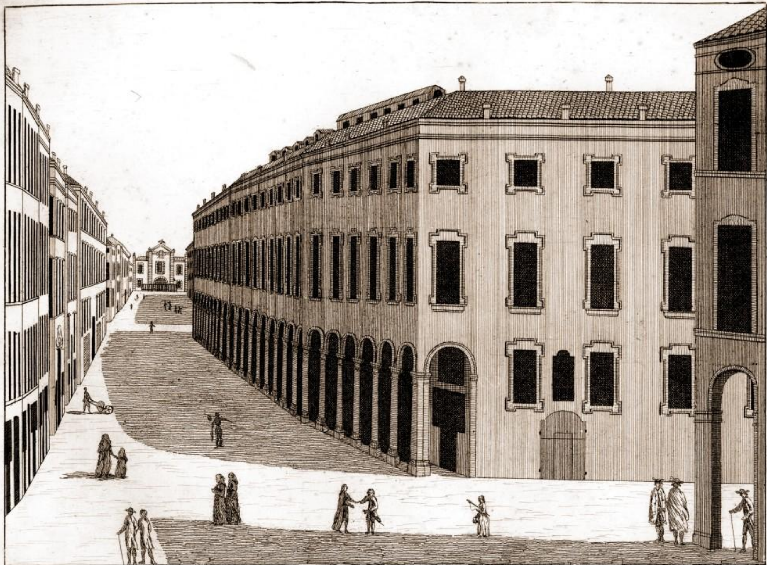
VEDVTA DEL COLLEGIO DE NOBILI SVLLA STRADA MAESTRA DI MODENA
