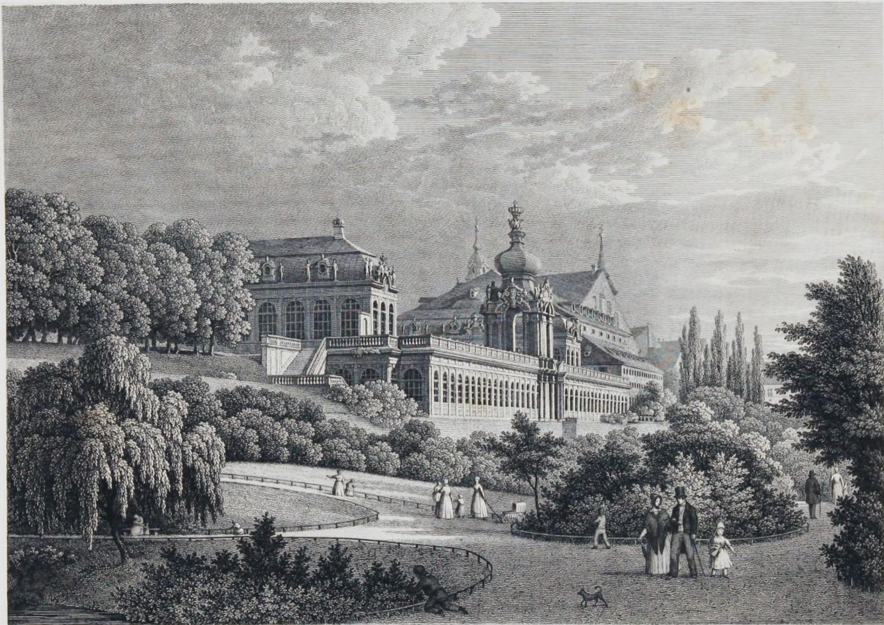
Außere Ansicht des Zwingers.
